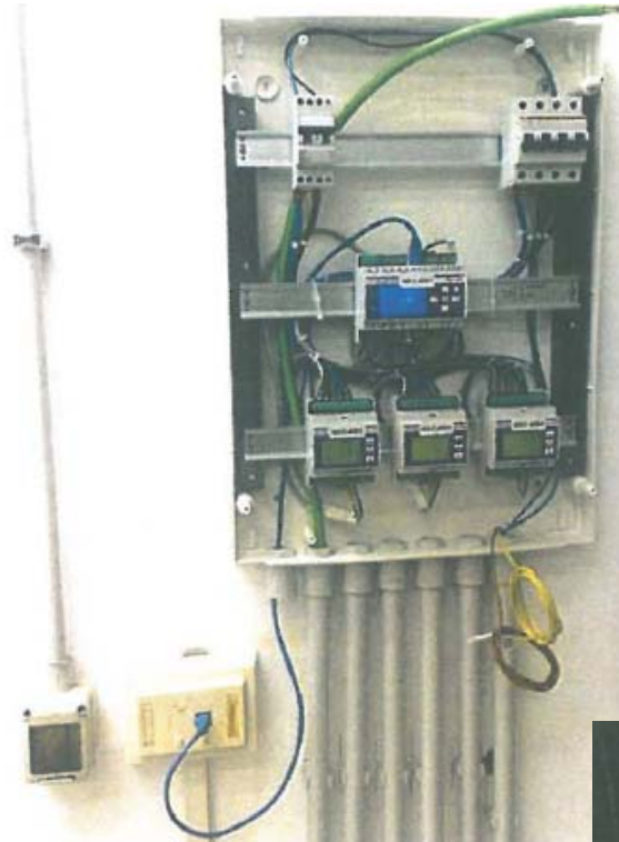
TA apribili fissati sulle sbarre di alimentazione del quadro generale di bassa tensione
